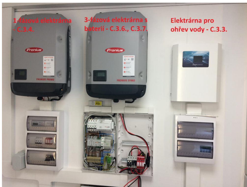
Příklady technologií, ukázka jejich umístění a vybavení rozvaděčů
